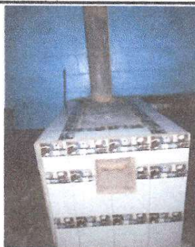
Foto 5: Mantenimiento a estufa rural, Sustitución de plancha de metal de 3 hornillas e Instalación de azulejo en estufa rural, area de cocina
