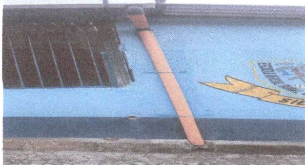
Foto 3: Sustitución de canal de pvc y Sustitución de bajada de agua pluvial de metal por tubo PVC 3" frente del establecimiento
