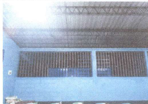
Foto 10: Sustitución de estructura de metal de ventana (por balcón) aula 1 y aula 2 al frente del establecimiento
