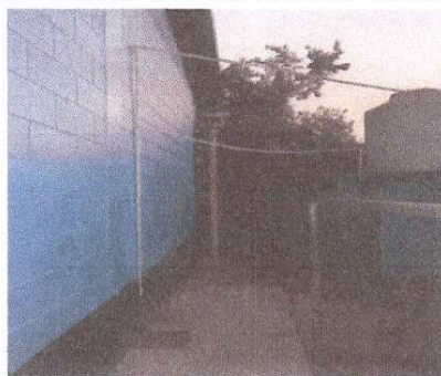
Foto 9: Instalación de tubería para agua potable
