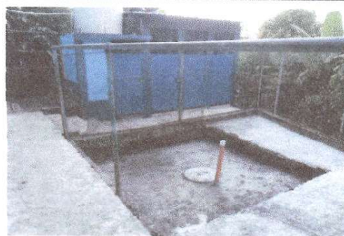
Foto 6: Sustitución de fosa séptica por biodigestor de 1300 Lts. Y Sustitución de tubería PVC línea principal aguas negras
