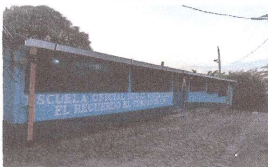
Foto 7: Pintura en muros exteriores del establecimiento
