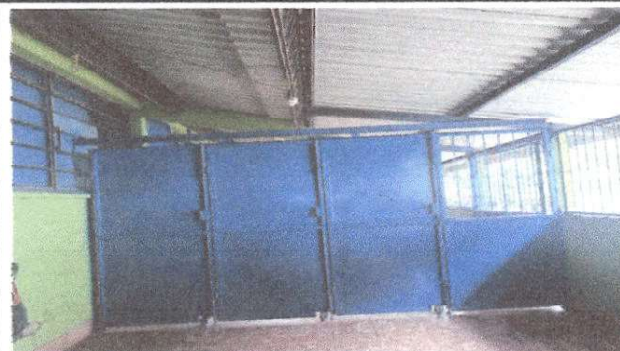
Foto 2: Mantenimiento a estructura (lijado, cambio de tubo , cepillado, aplicación de pintura) y mantenimiento a portones, corredor del establecimiento
