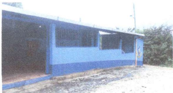
Foto1: Sustitución de lámina, por lámina troquelada aluzinc calibre 26. En corredor, baños y bodega
